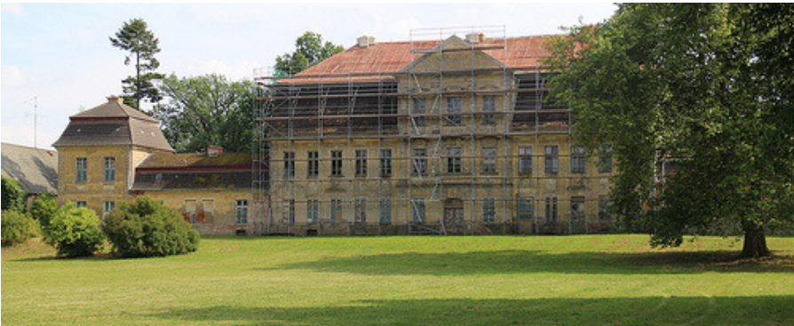
Die Gerüste stehen, die Arbeiten gehen voran...
